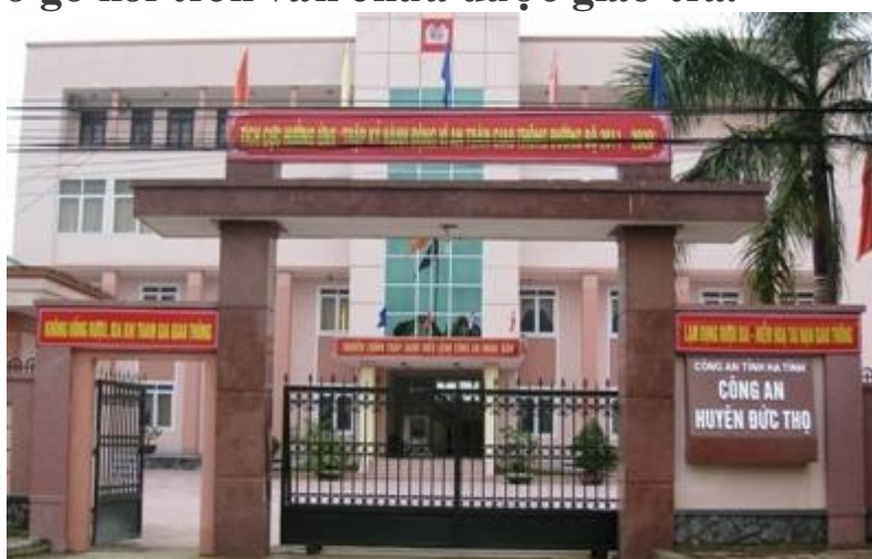
Trụ sở Công an huyện Đức Thọ
